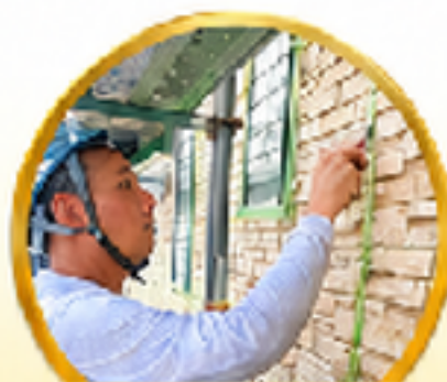
シーリング・補修
